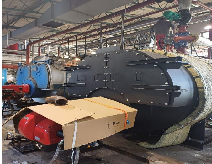
Slika 16. Ugradnja toplovodnog kotla 3,2 MW u kotlovnici u vojarni „Pukovnik Mirko Vukušić“, Zemunik Donji
