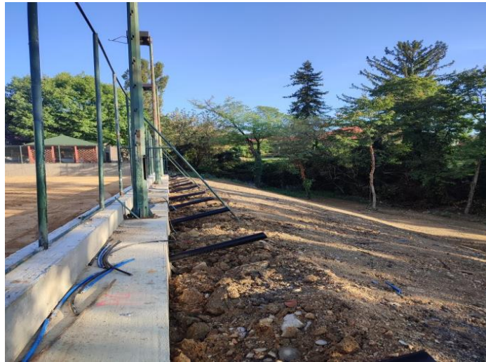
Slika 20. Sanacija klizišta uz vojarnu „1. hrvatski gardijski zbor“, Zagreb
