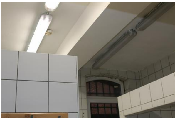
Fotografija 18. (Kupaonica u Lepoglavi nakon sanacije)
