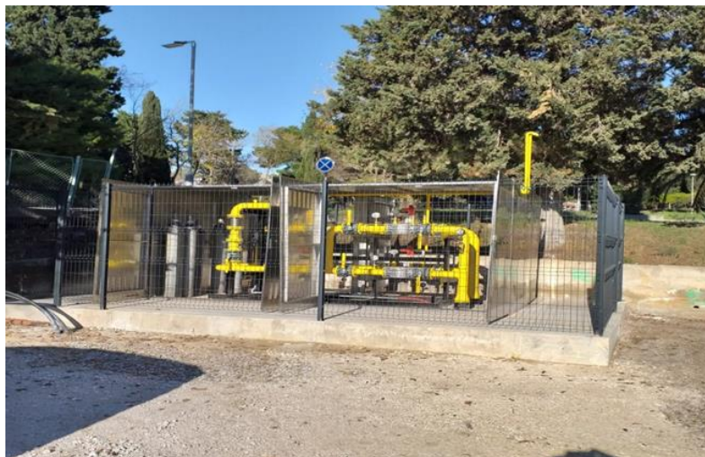
Slika 15. Plinska regulacijska postaja u vojarni „Admiral flote Sveto Letica-Barba”, Split
