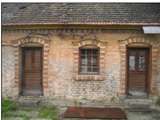
Kuća s okućnicom, Jurišićeva ulica 38
