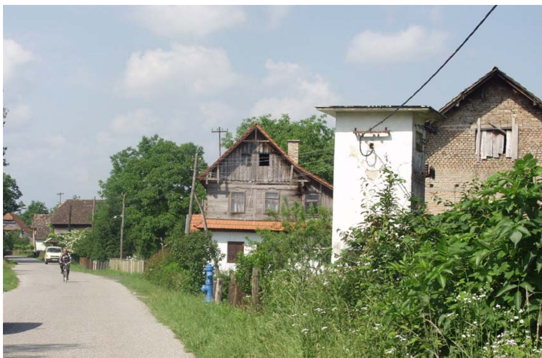
Slika 57. Trafostanica u naselju Suvoj
