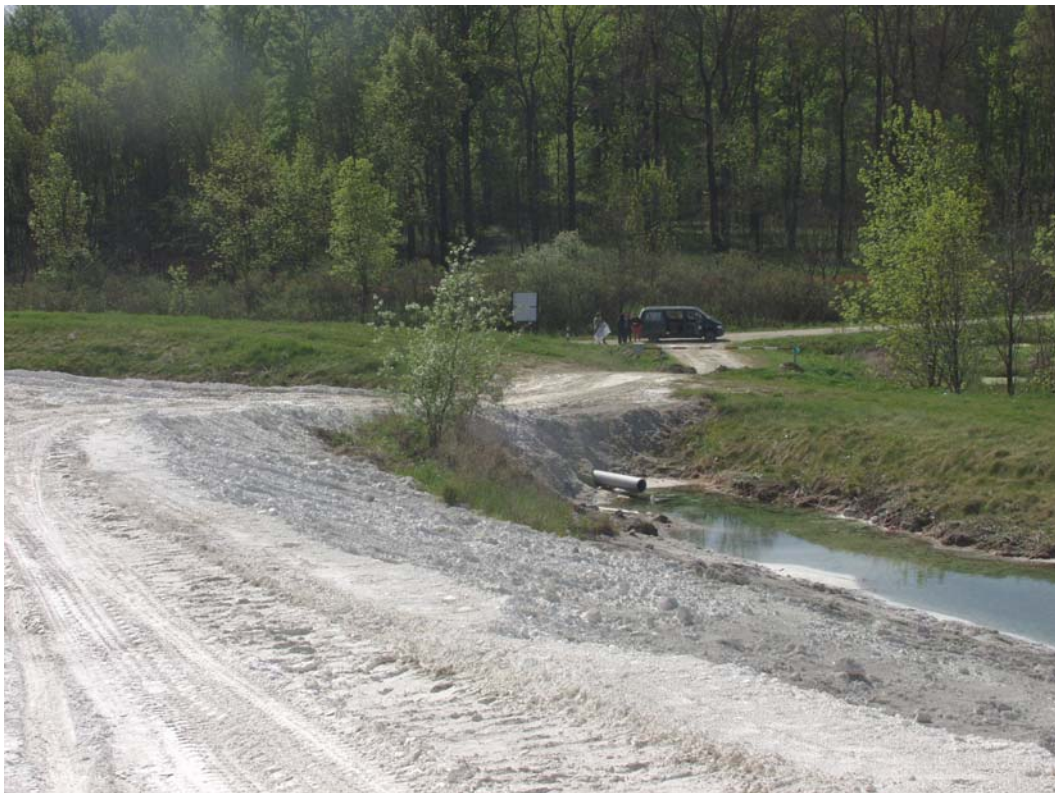
Slika 56. Kanal kraj deponije proizvodnog otpada u Kutini
